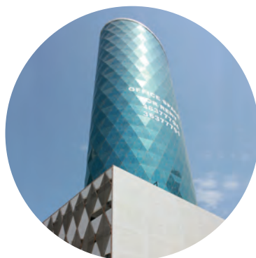
Бизнес-центр Millennium Tower, Манاما, Бахрейн
